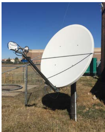
Fig 4 VSAT Satellite Antenna
